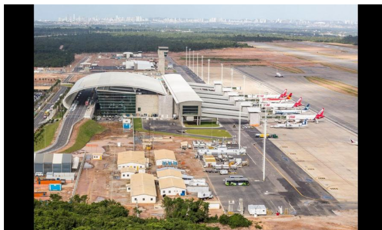
Figura 1 – Aeroporto Internacional de São Gonçalo do Amarante, RN
