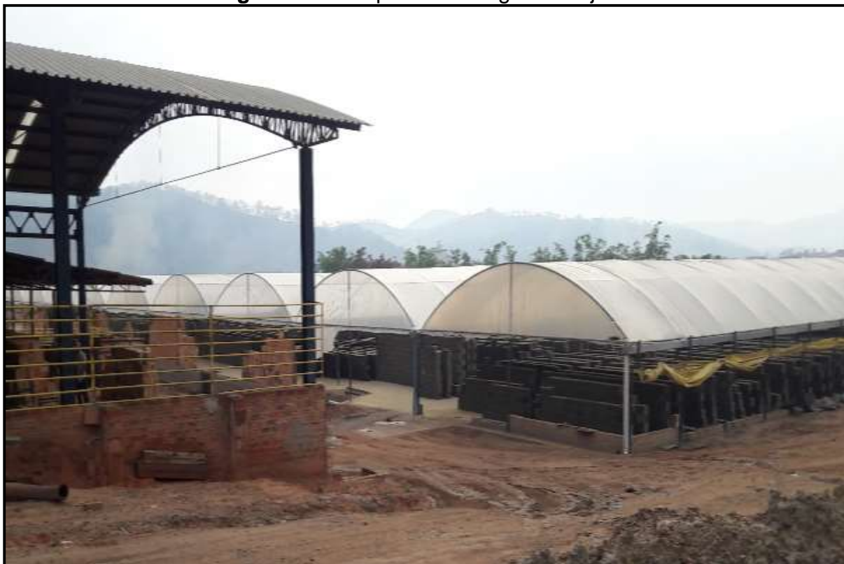
Figura 21 – Galpão de secagem de tijolos
