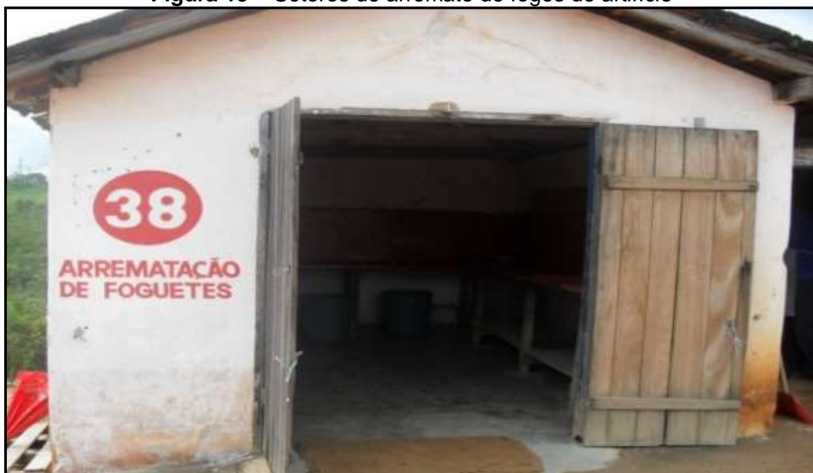
Figura 15 – Setores de arremate de fogos de artifício
