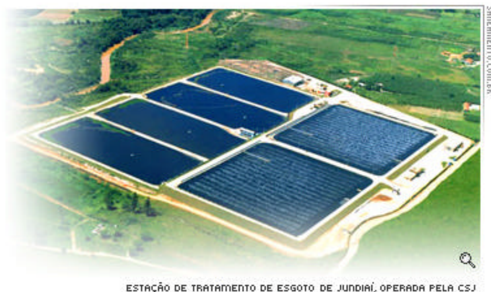
Figura 7 – Estação de Tratamento de Esgoto de Jundiaí
