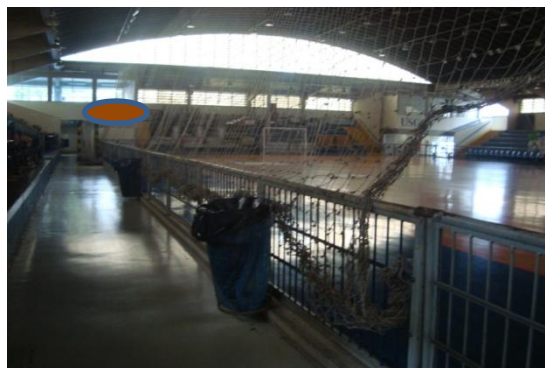
Figura 70. Ginásio de esportes, localizado no campus A .
