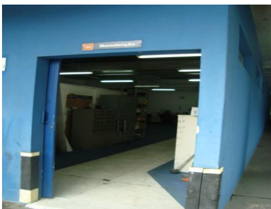
Figura 95. Manutenção, localizada no campus B , vista externa.
