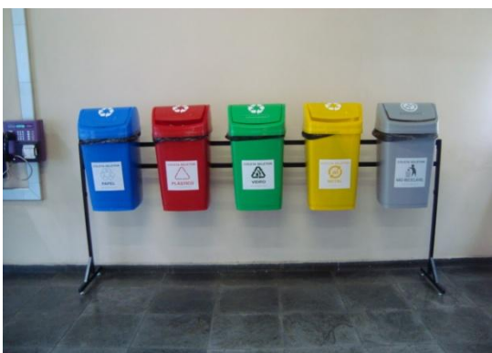
Figura 115. Coletores seletivos instalados na entrada principal do prédio A, localizado no campus A.
