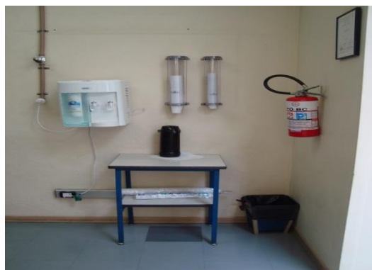
Figura 123. Bebedouro localizado na Recepção de atendimento administrativo, no Anexo A.
