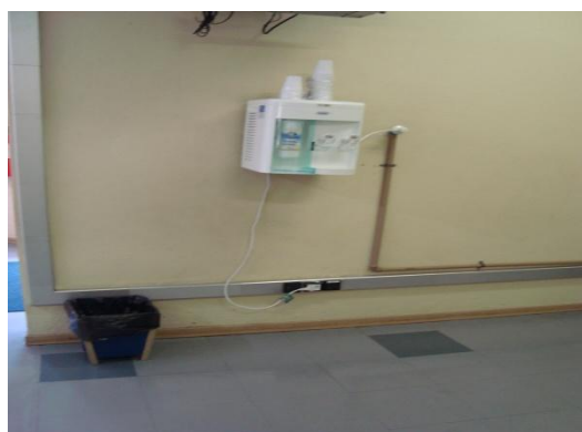
Figura 121. Bebedouro localizado na Recepção de atendimento ao público, no Anexo A.
