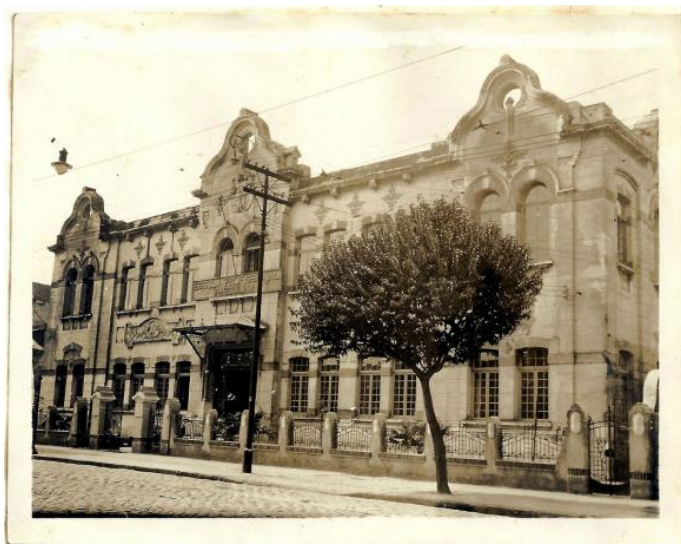
Figura 2. Fachada do edifício escolar na Rua Piratininga nº105, Brás.
