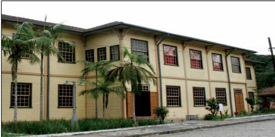
Figura 4: Estilo arquitetônico da Vila de Paranapiacaba
