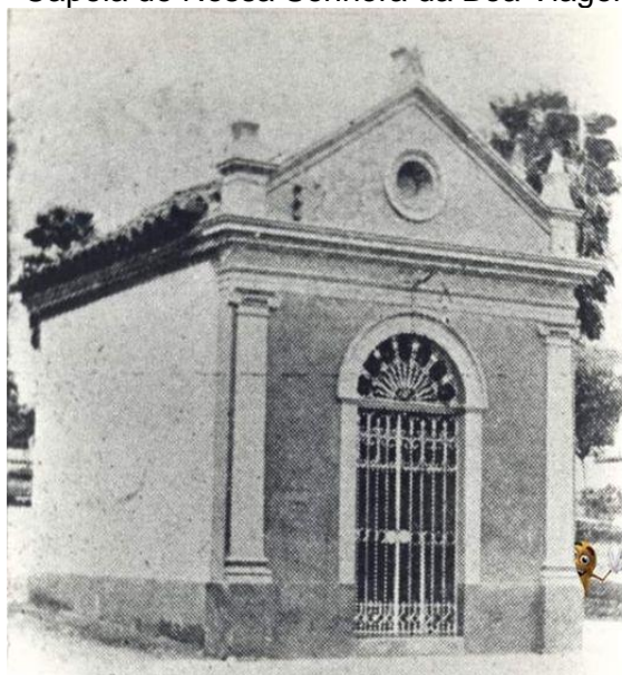
Figura 12 - Capela de Nossa Senhora da Boa Viagem, em 1814
