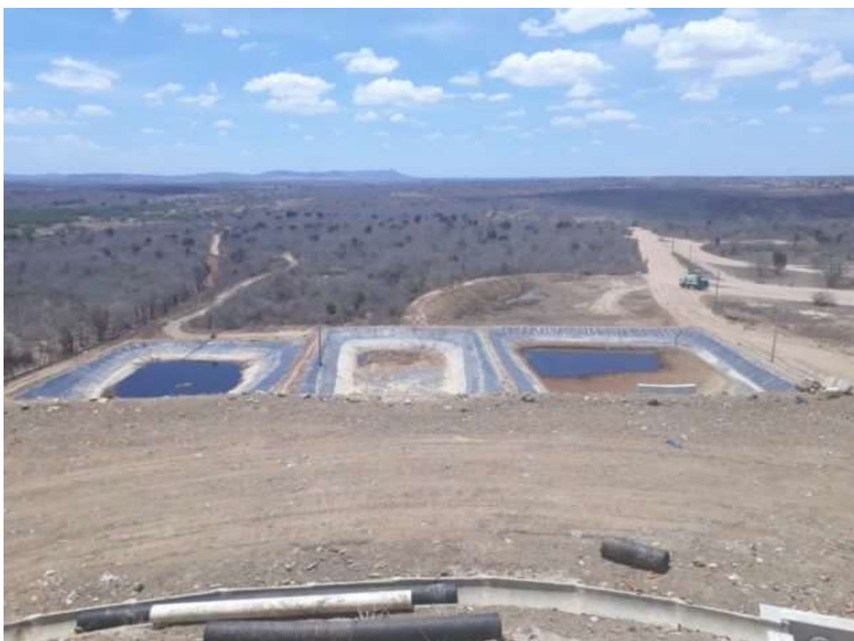
Figura 17 – Estação de Decantação do Aterro Sanitário Privado em Campina Grande
