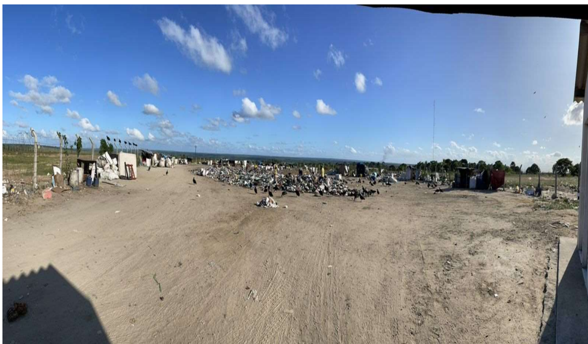
Figura 34 – Estação de Triagem dos Cooperados em Mamanguape
