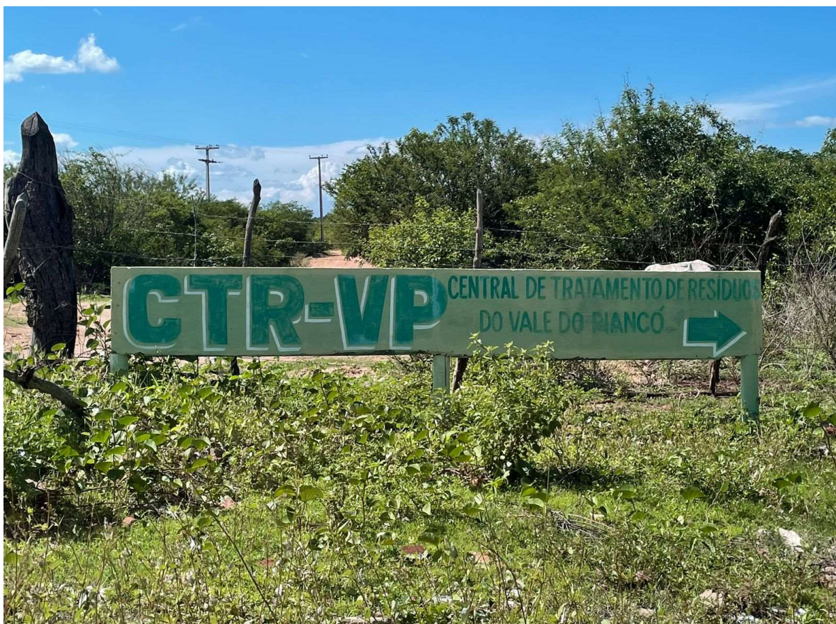
Figura 40 – Central de Tratamento de Resíduos de Piancó
