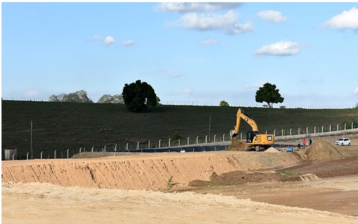
Figura 23 – Célula do Aterro Sanitário Privado em Guarabira
