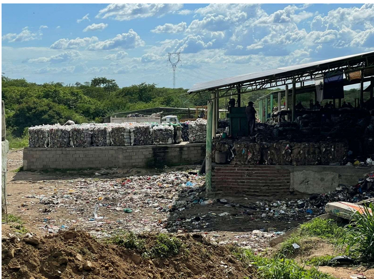
Figura 41 – Galpão dos Cooperados na CTR de Piancó
