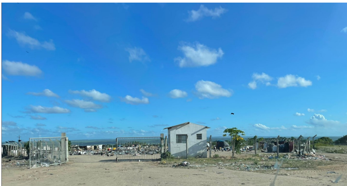
Figura 35 – Estação de Transbordo de Mamanguape
