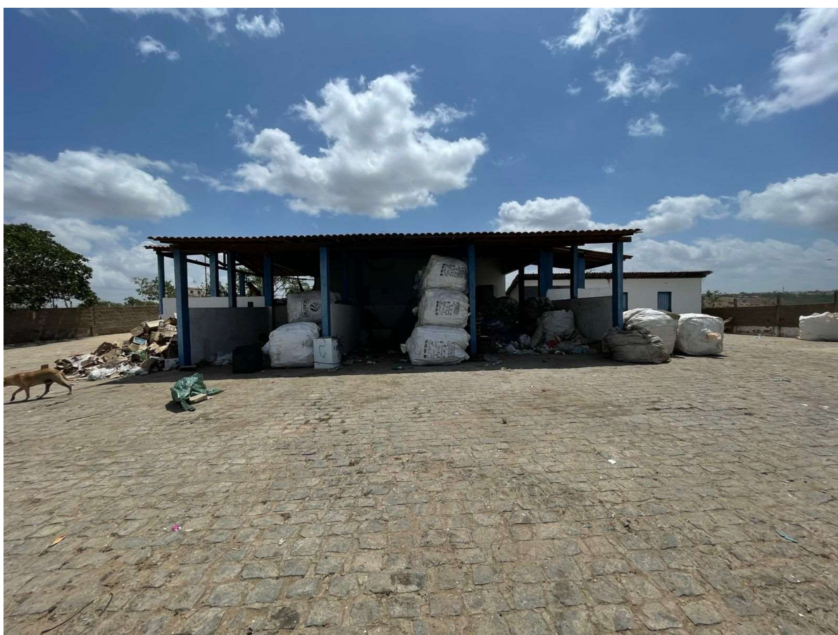
Figura 9 – Estação de Transbordo de Araruna
