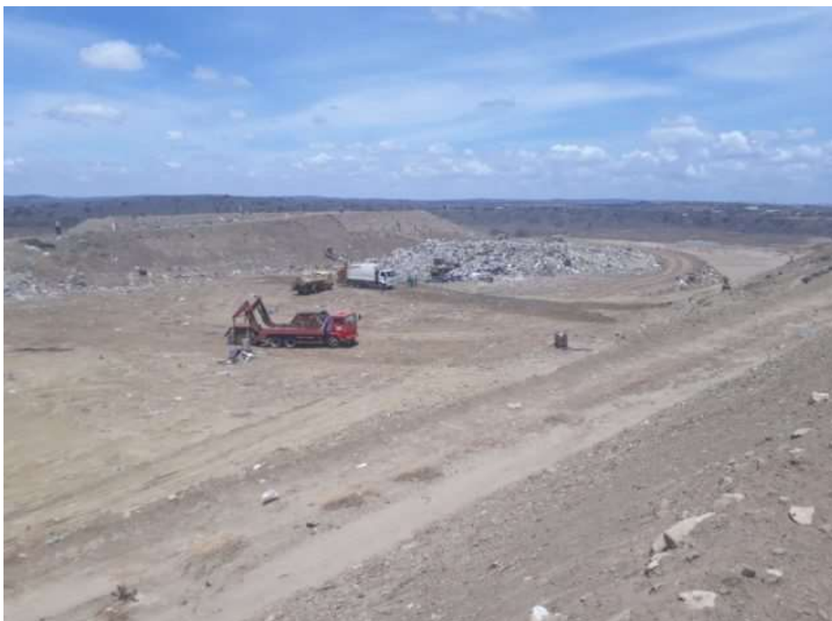
Figura 18 – Célula do Aterro Sanitário Privado em Campina Grande
