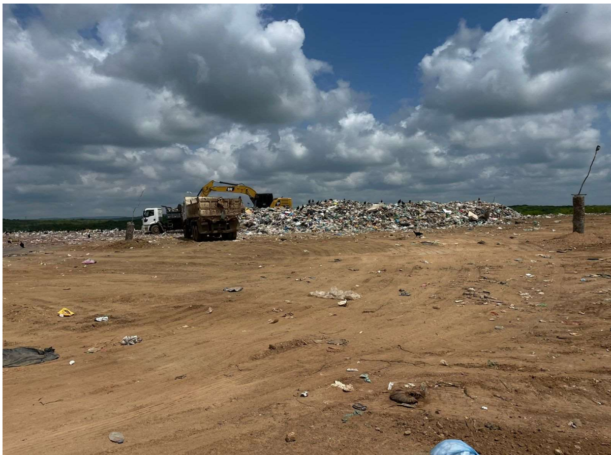
Figura 43 – Célula do Aterro Sanitário Privado em Sousa
