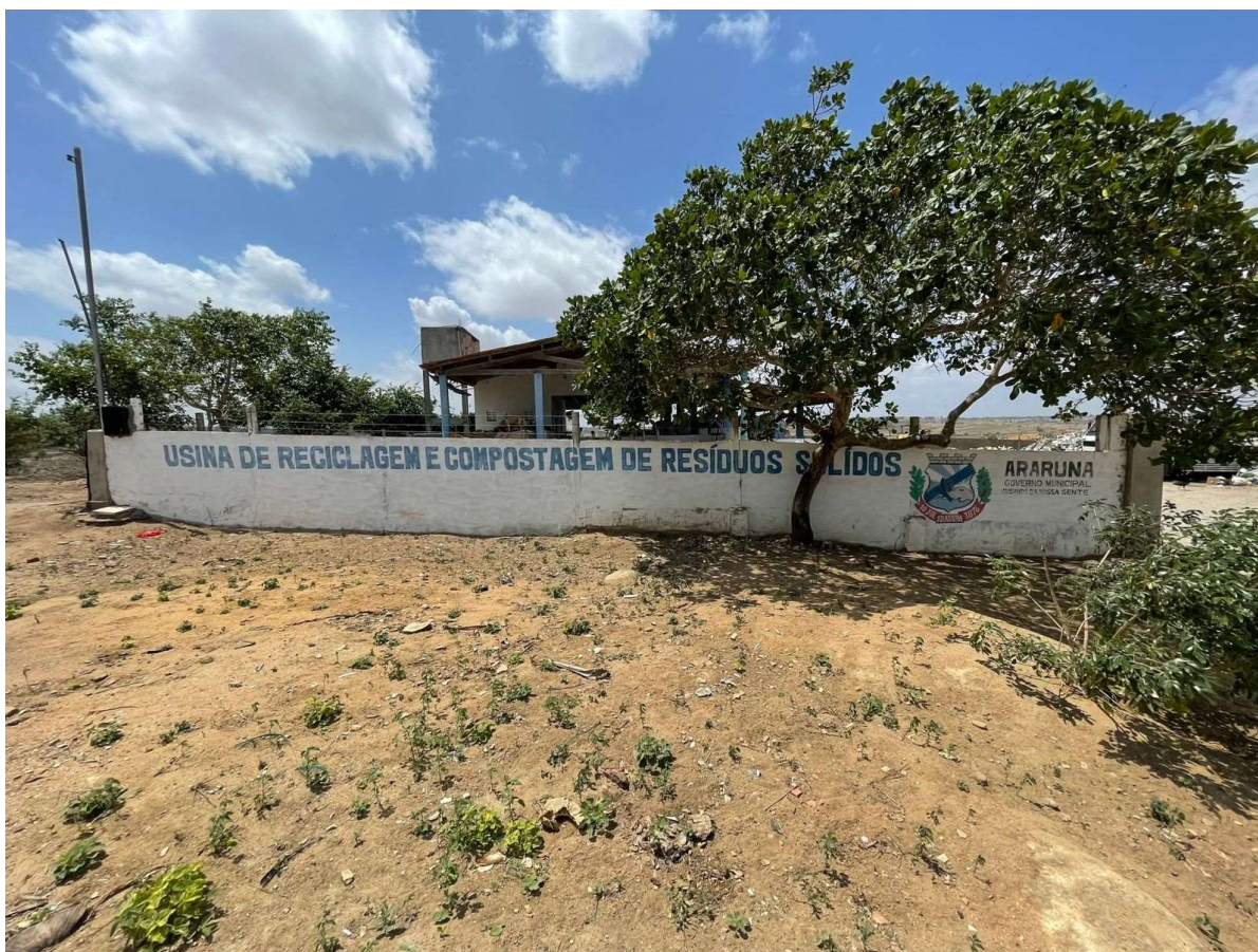
Figura 8 – Usina de Reciclagem e Compostagem de Araruna
