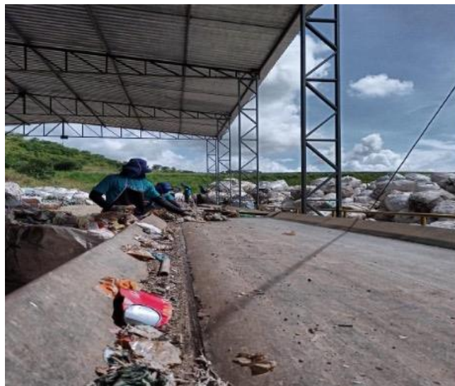
Figura 11 – Aterro sanitário de Juazeiro do Norte (pertencente a uma sociedade privada)
